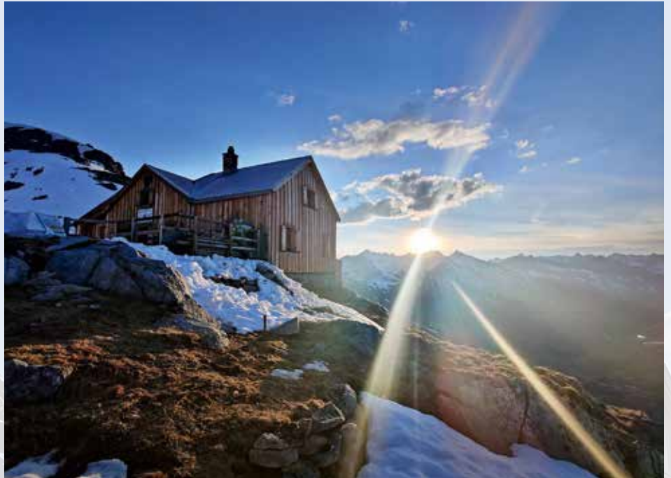
Hochgelegen: Um die Rauhekopfhütte zu versorgen ...
