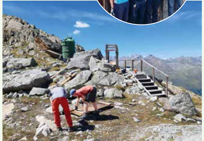
Das alte „Fluchtkogelblick“-Häusle wurde abgerissen
