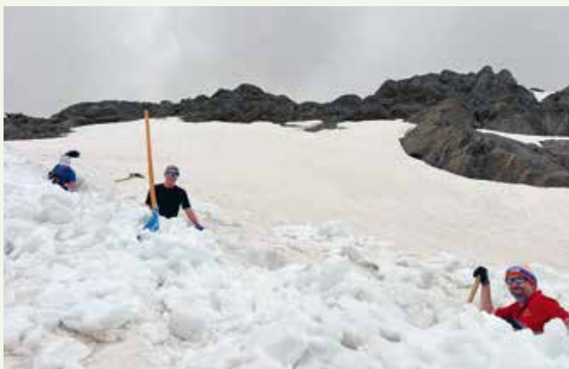
Die Wasserleitung muss freigelegt werden
