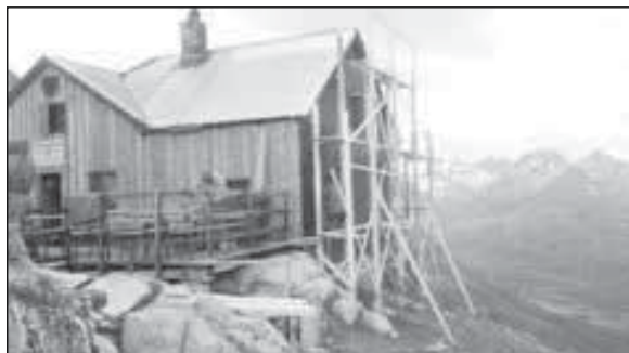
Das Gerüst steht
