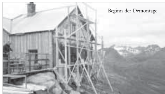
Die Wände werden verschalt
