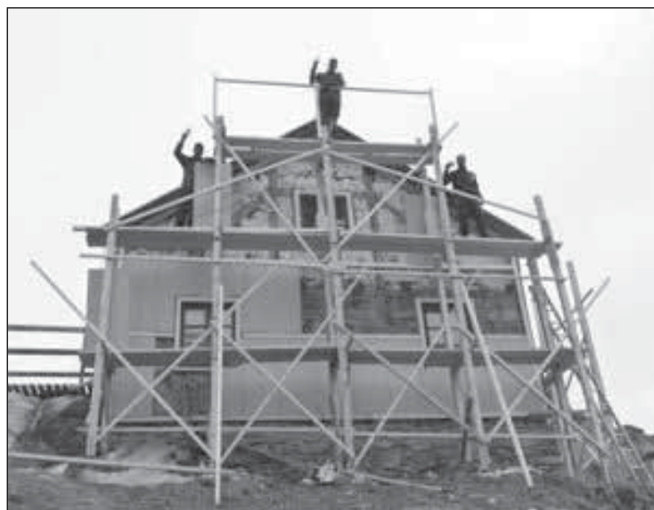
Richtfest fürs fertige Gerüst
