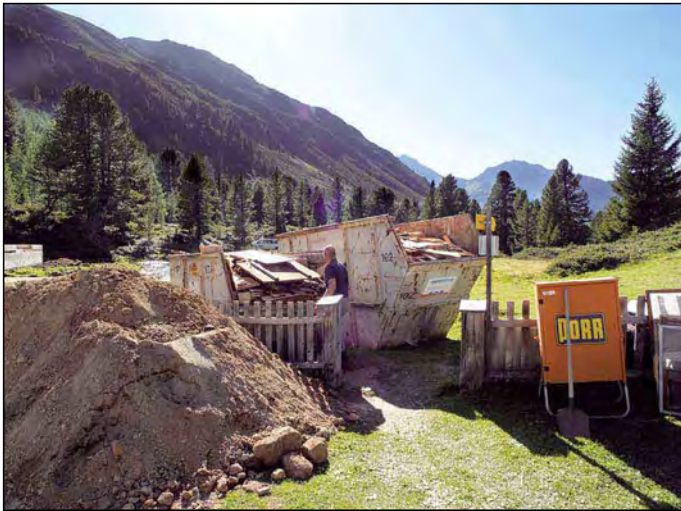
Insgesamt wurden fünf Container mit Holz und Bauschutt gefüllt
