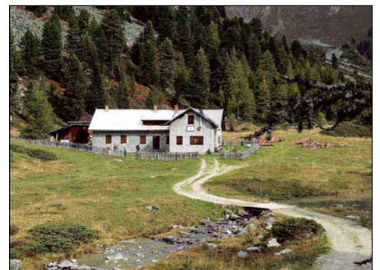
Die Verpeilhütte vor der Renovierung Foto: Wolfgang Berger
