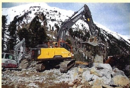
Abtragung von Fels für das Fundament des neuen Anbaus
