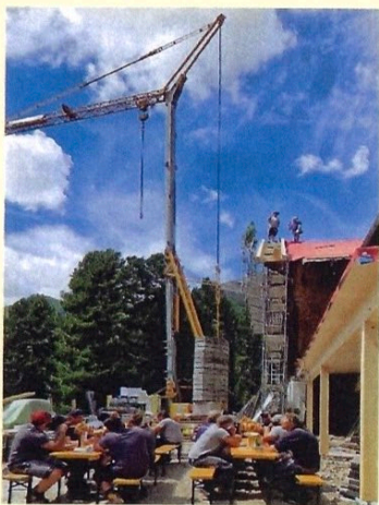
Richtfest am 26. Juli 2024 für den Anbau
