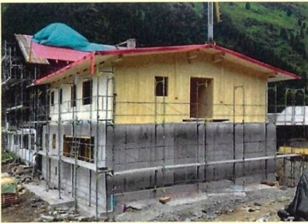
Der Mitte Juli 2024 fertiggestellte Rohbau des neuen Anbaus
