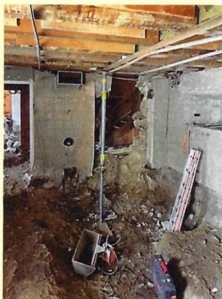
Entkernung und Tieferlegung des Bodens im Küchenbereich
