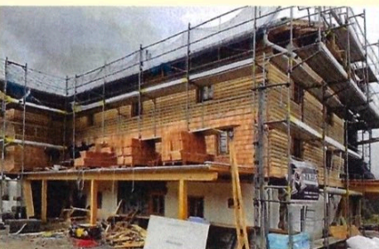
Neuverschindelung der Südseite des Gepatschhauses
